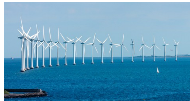
Nella foto: un impianto offshore
