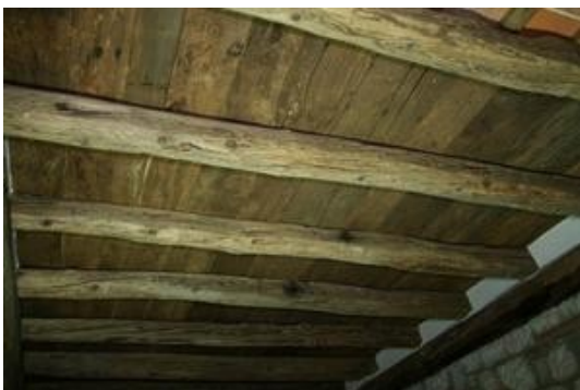
Fig. 3 – Solaio in legno; si notano le travi ad una distanza di circa 80-100 cm l'una dall'altra e le tavole appoggiate su di esse. Sopra le tavole viene realizzato un riempimento (massetto) e su questo viene posato il pavimento.
