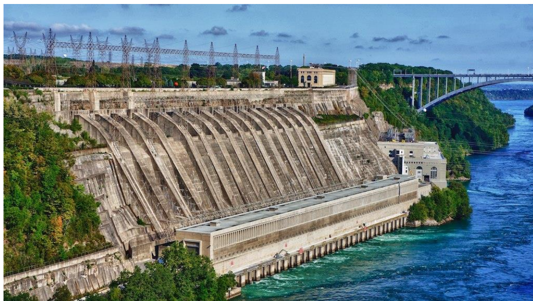
La centrale idroelettrica Sir Adam Beck 1 & 2, Ontario, Canada
